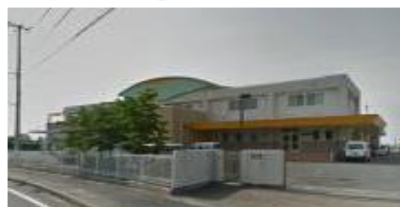
新居浜市学校給食センター
